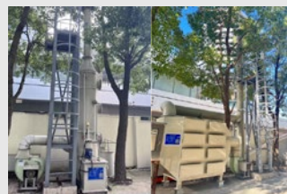
處理裝置更換前 處理裝置更換後
